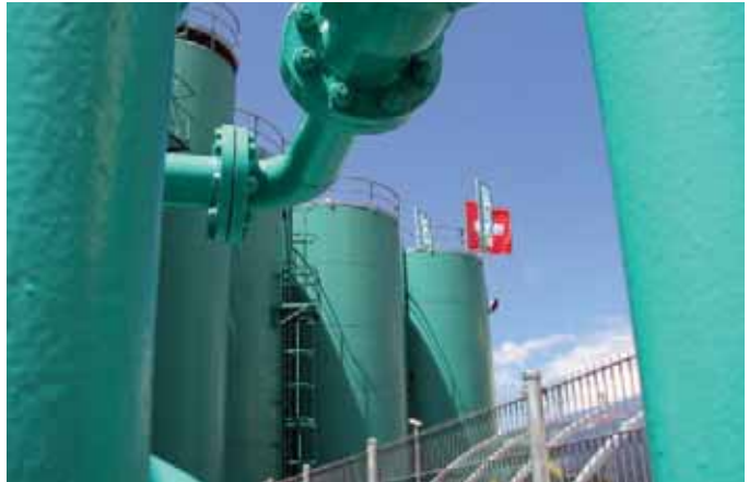
Les installations de citernes constituent un élément essentiel du processus de production coûteux et certifié ISO de la société Motorex.
